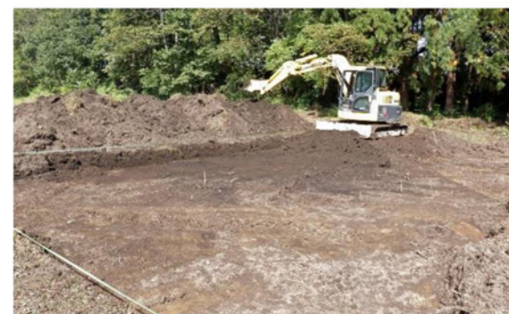
重機による表土除去状況（南東から）
