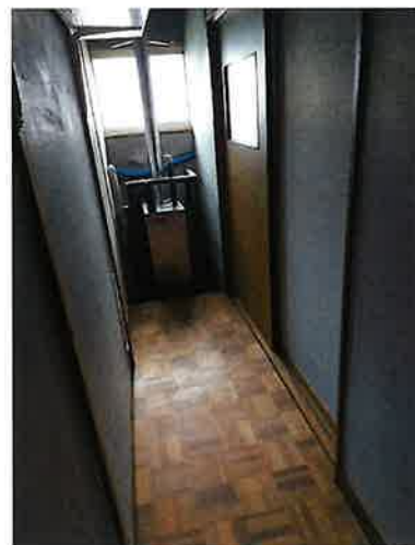
1F ボイラー
