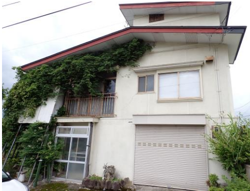
東側からの写真になります。 駅も近く、立地も大変いいです。
