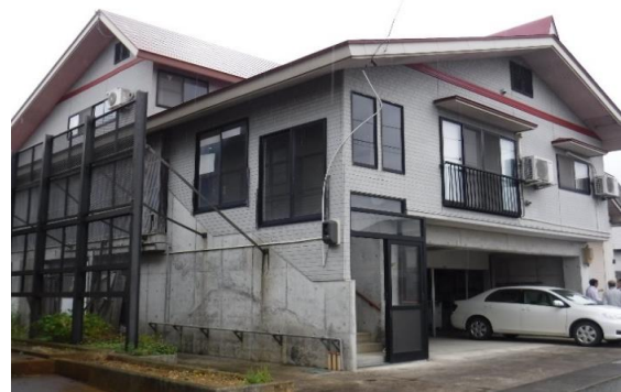
南側からの写真になります。 雪止めフェンス、融雪装置もついており 雪対策も万全です。
