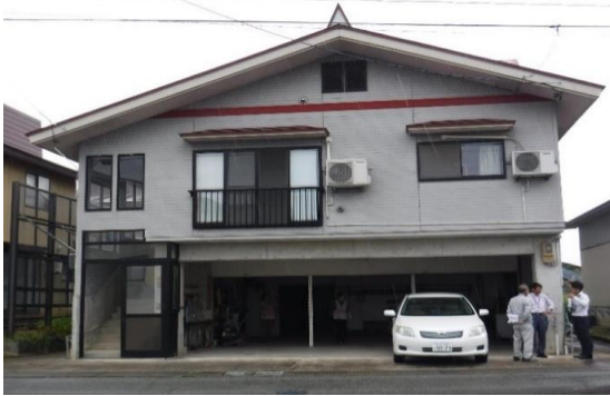
正面(東側)からの写真になります。 駐車場も広く、3台駐車可能です。
